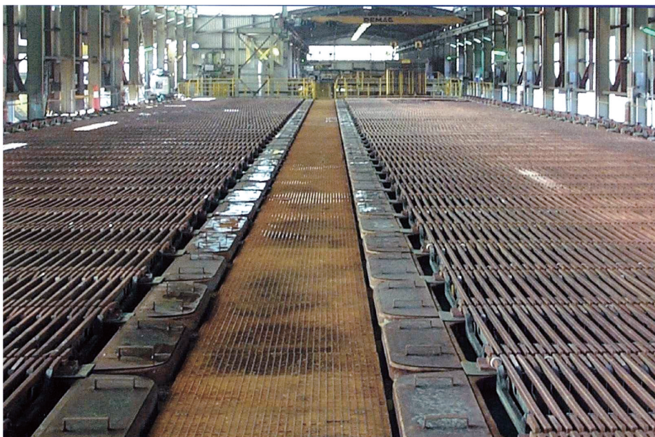
Слика 2-4 Погон за електрорафинација на бакар
